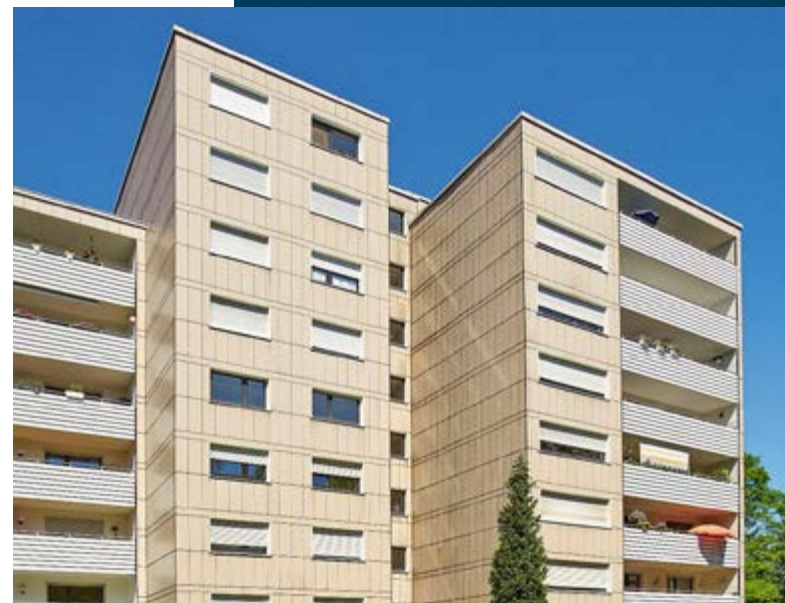
MWB-Wohnhaus an der Lerchenstraße
